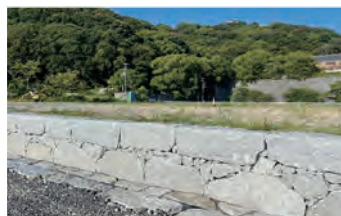
城山公園自然石側溝整備工事
