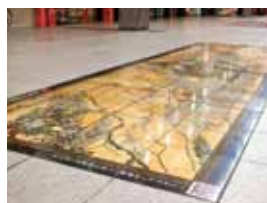
松山城下屏風園大街道施工
